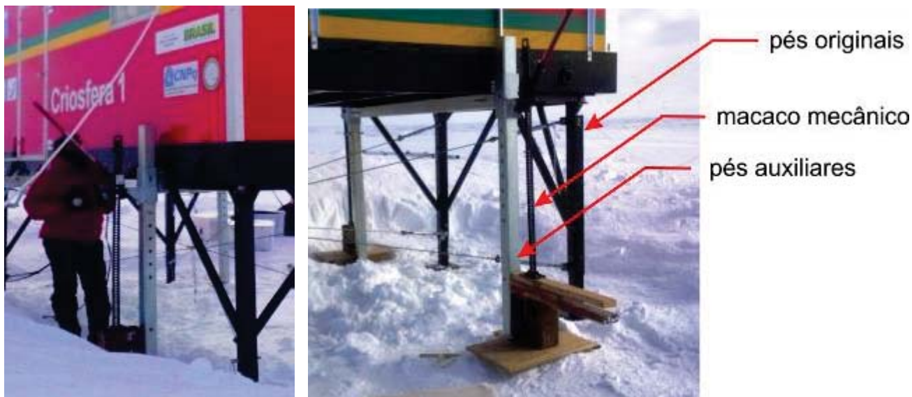
Figura 18 – (esquerda) colocação de macaco em pé auxiliar visando elevação do Criosfera 1 (40 cm); (direita) estruturas de elevação do módulo.
