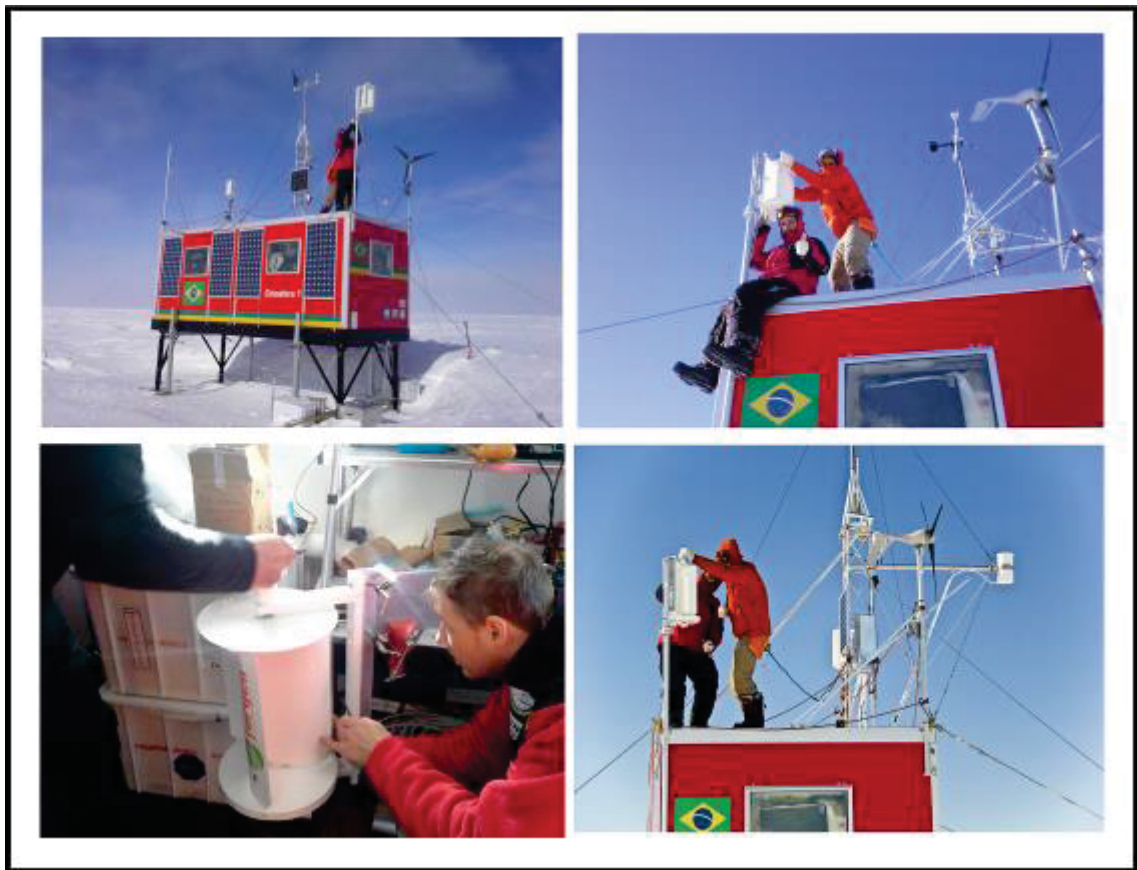
Figura 17 – Teste e montagem das turbinas eólicas Forgen Ventus 70 no Criosfera 1.
