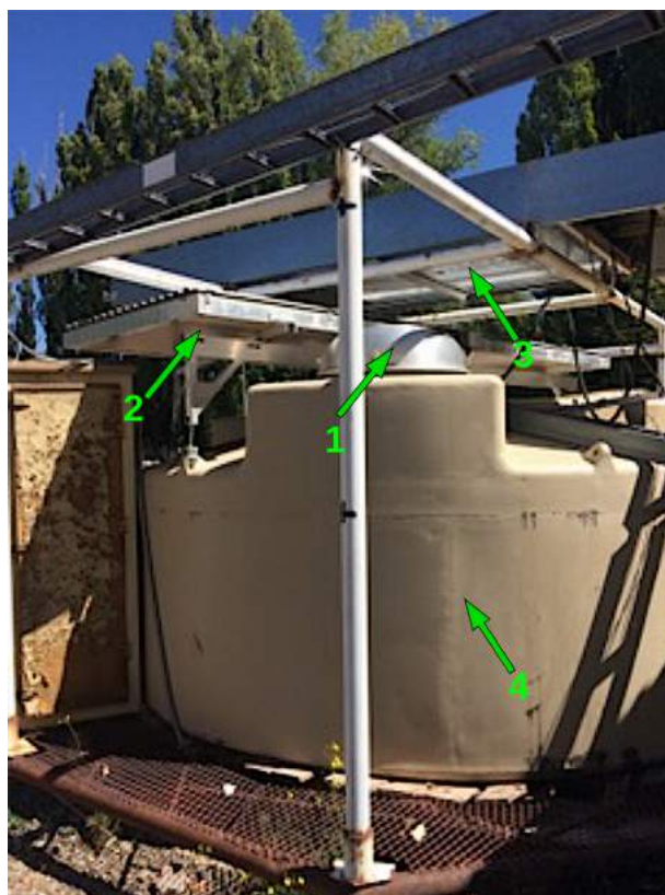
Figura 3.25: Foto do WCD Gianni Navarra após a instalação do SSD e UUB. 1: Domo metálico sob o qual fica instalada a UUB; 2: SSD; 3: RPC superior; 4: WCD. A RPC Inferior está abaixo grade de aço que forma a base da estrutura.
