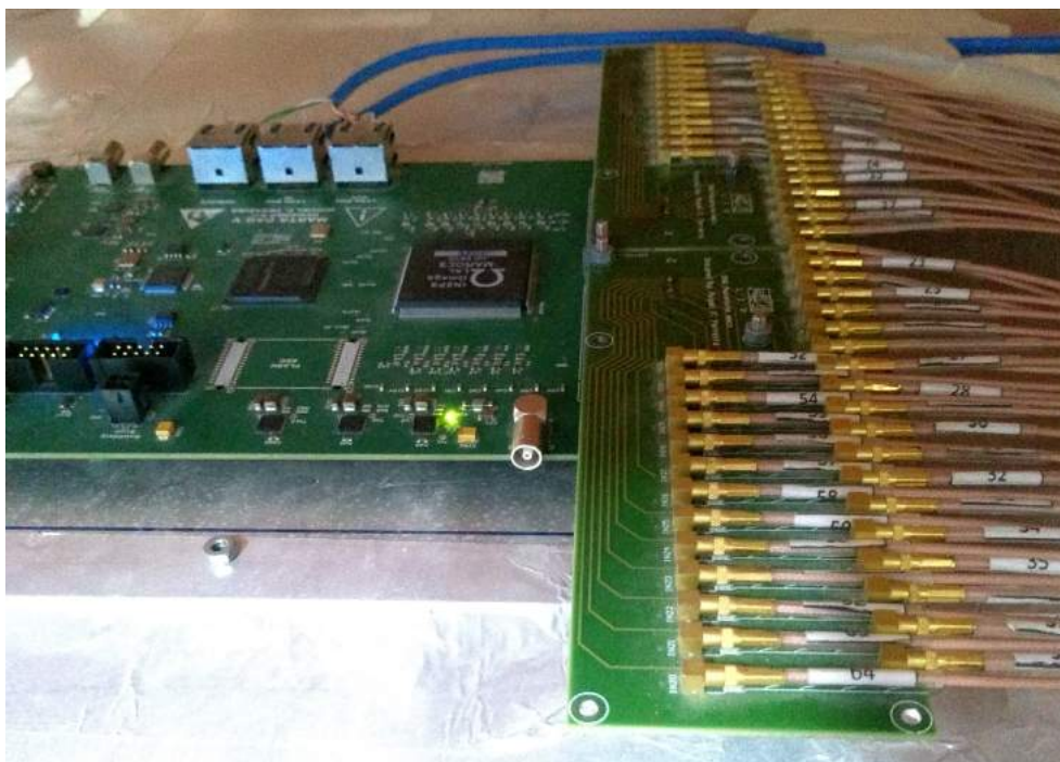
Figura 3.7: Foto de uma Front-End com uma Mezzanine , recebendo os cabos coaxiais de uma RPC.
