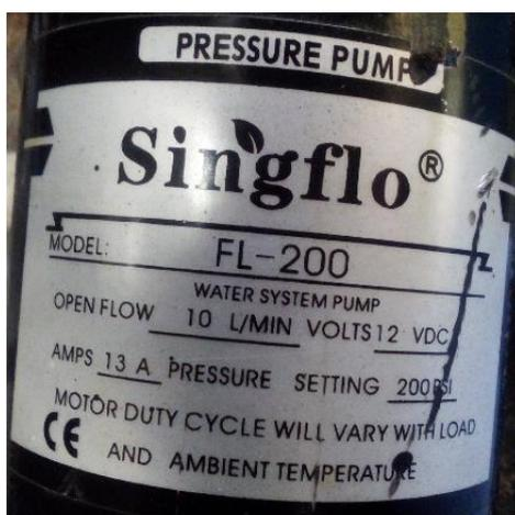
FIGURA 47 – Placa de identificação da bomba d'água.
