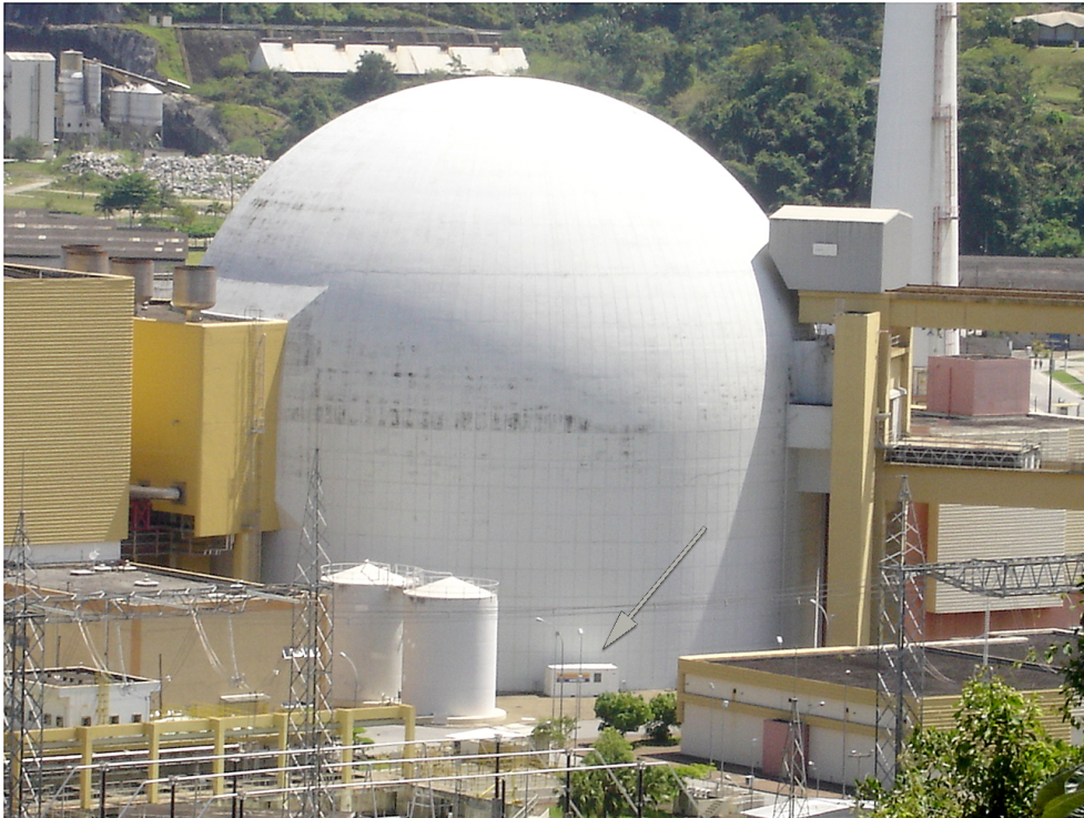
Figura 5.2: Container colocado a cerca de 25 m do núcleo do reator Angra II
