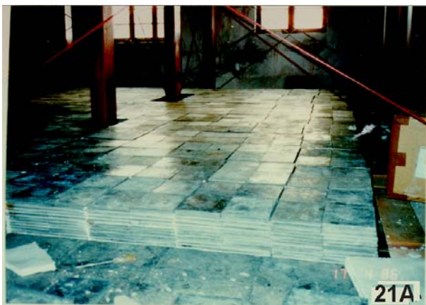
Aspecto de uma das câmaras da CBJ, vendo-se o piso de chumbo usinado e parte da estrutura de apoio.
