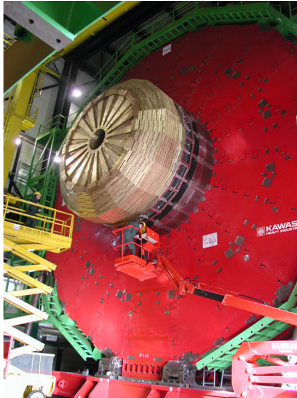
Figura 4.9: Instalação de uma das tampas do HCAL.
