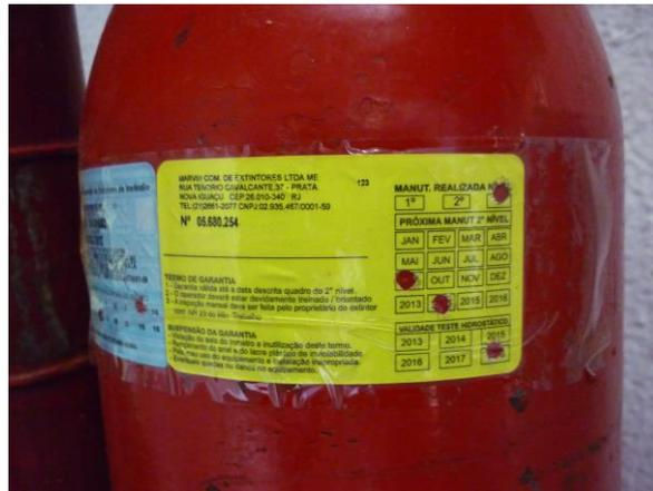
Extintor de incêndio com data da inspeção técnica de manutenção e prazo dentro da validade.
