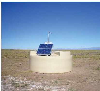
Tanque do Observatório Pierre Auger
