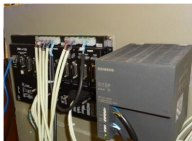
Figura 25: Controlador e drivers DMC4183 da Galil Motion e fonte de alimentação 24 VDC da Siemens. [Fonte: grupo IMA - LNLS]
