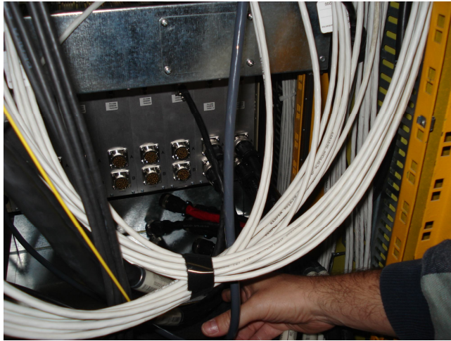
Figura 22 - Detalhe da instalação dos cabos CAN
